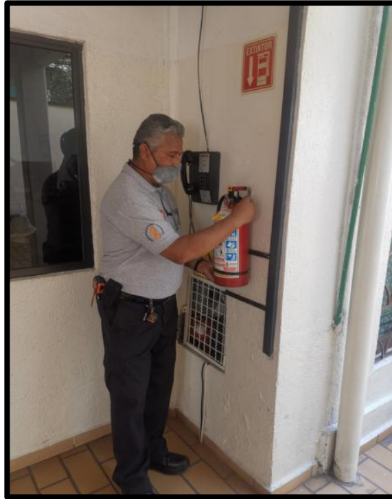
RECARGA DE EXTINTORES
